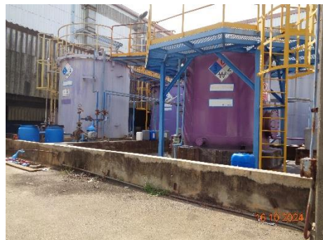
ภาพที่ 2-29 การสร้าง Bunding บริเวณพื้นที่ตั้งถังบรรจุน้ำเคมีที่เป็นของเหลว( H_2SO_4 )
