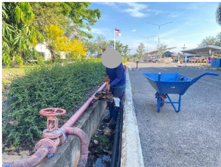
การขุดลอกรางระบายน้ำฝนภายในโรงงาน
